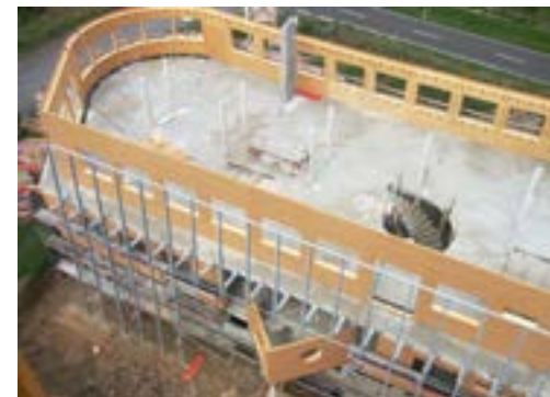
Das Bürogebäude des Heizkesselherstellers ÖkoFen im bayerischen Mickhausen ist ein Mischbau aus Stahlbeton-Stützen und -Decken sowie vorgefertigten Holzrahmenbau-Außenwand-Elementen.
