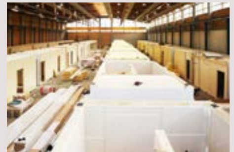
Die serielle Montage von Raummodulen im Werk erlaubt eine witterungsunabhängige Vorfertigung bei optimaler Qualität.
