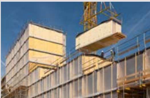
Der Begriff des Modulbaus wird regelmäßig mit vorgefertigten Raumzellen assoziiert (unten). Raummodule können aber auch aus modular konzipierten Einzelelementen erst vor Ort montiert werden (oben).
